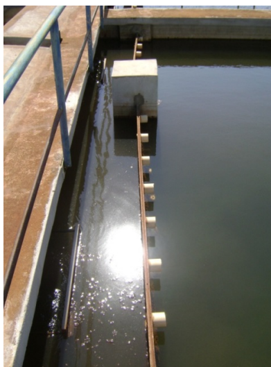
Figura 46: Entrada da água nos decantadores
