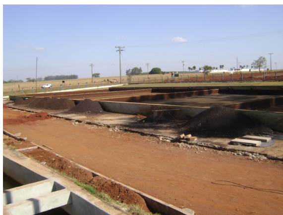
Figura 49: Leitos de secagem
