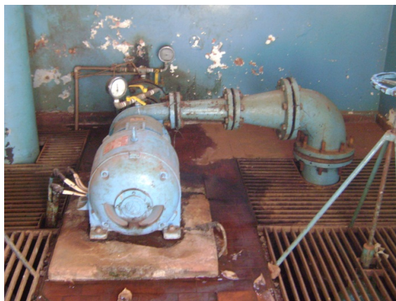
Figura 52: Vazamento Bomba 03
