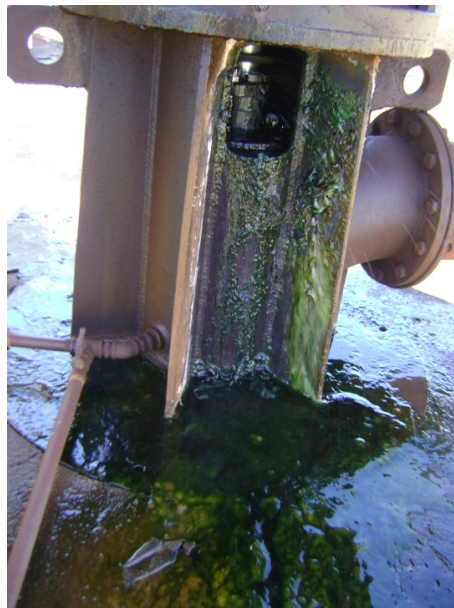
Figura 22: Vazamento Poço 001
