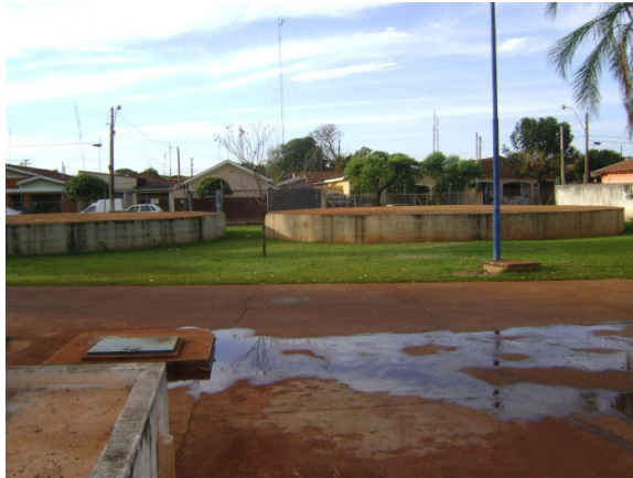
Figura 27: Reservatórios semienterrados
