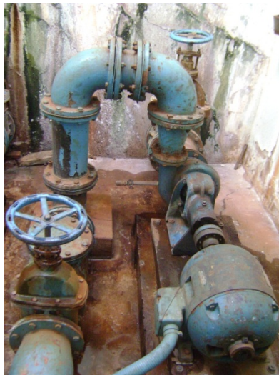
Figura 30: Vazamento na bomba
