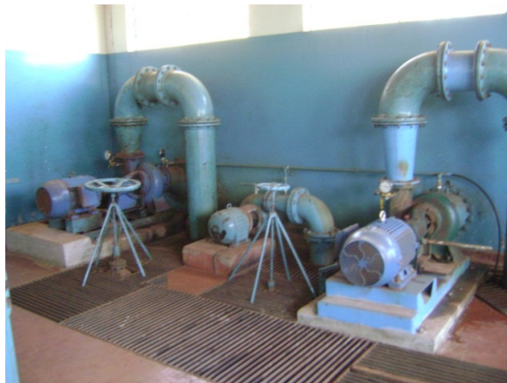
Figura 15: Casa de bombas (Água bruta)
