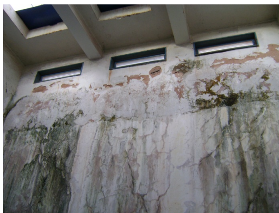
Figura 31: Infiltração nas paredes da casa de bombas
