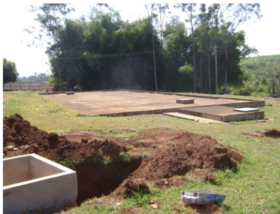
Figura 32: Reservatório enterrado retangular
