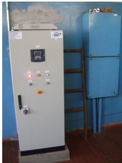
Figura 17: Inversor de frequência
