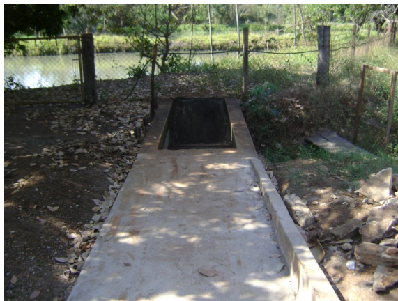
Figura 12: Canal após gradeamento e tubulação enterrada
